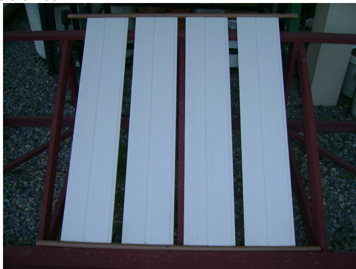
Figura 3 – Detalhe do painel de PVC de 25 mm de diâmetro com cortes de 20 cm de comprimento e espaçamento de 4 cm para o encaixe do forro de PVC. (Pelotas, 2009)
